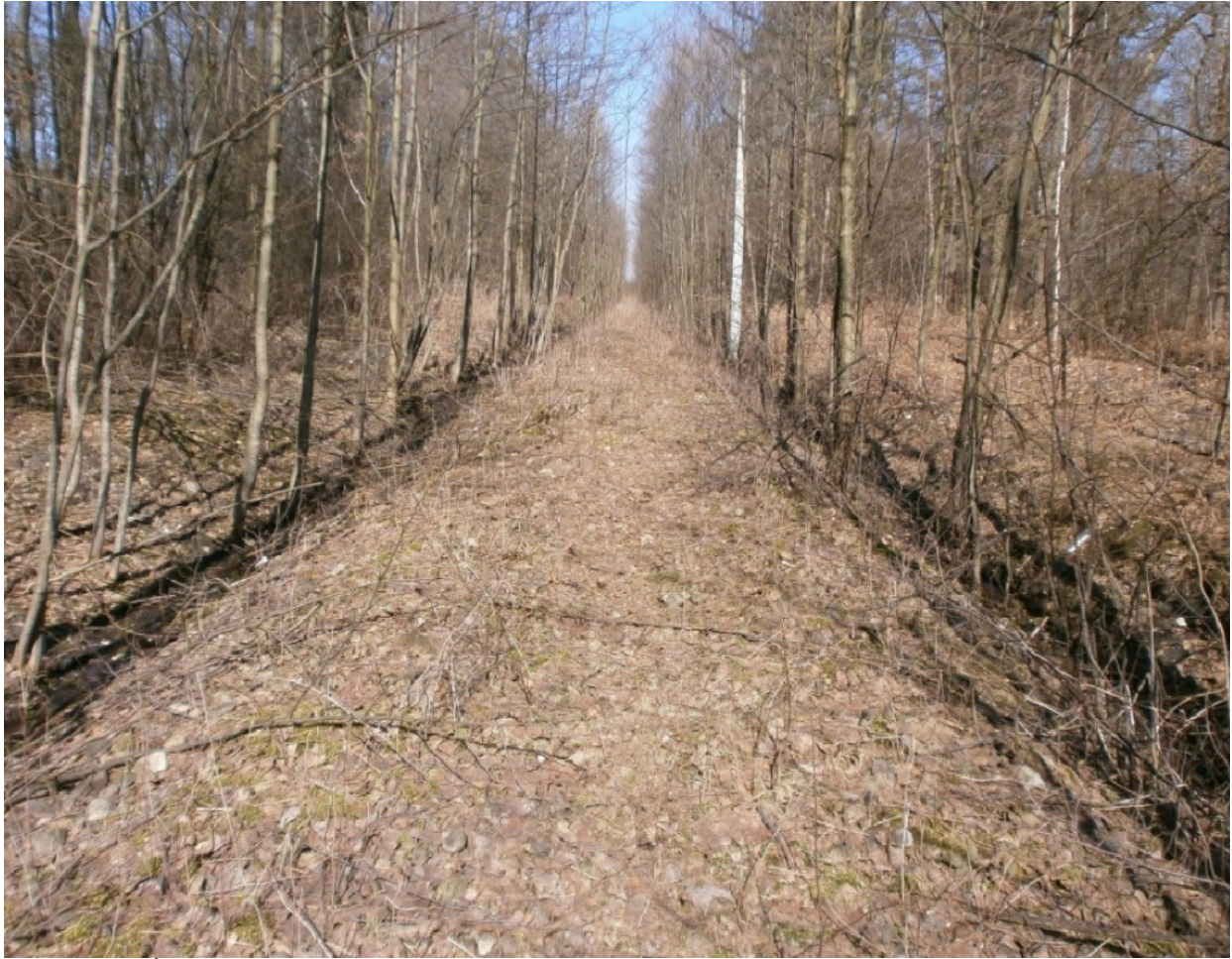
Ilustracja 11: Ślad po linii kolejowej - linia oficjalnie jest linią czynna (rejon Alwerni).
