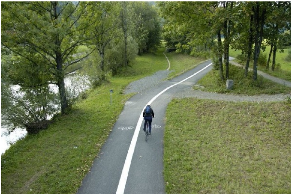
Ilustracja 8: Droga asfaltowa wykonana w terenie zalewowym.
