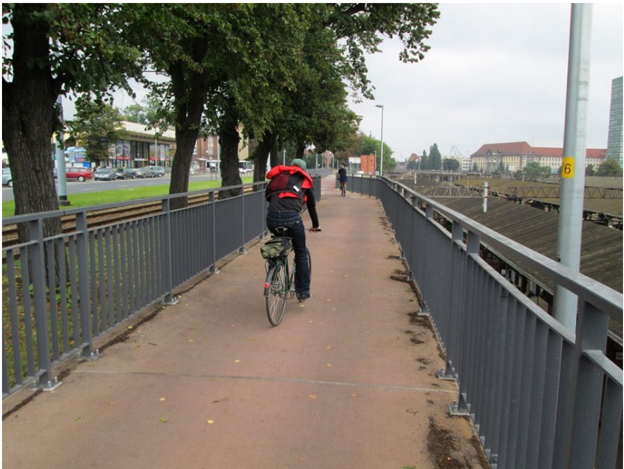
Ilustracja 6: Kładka stokowa w Gdańsku nad stacją kolejową.
