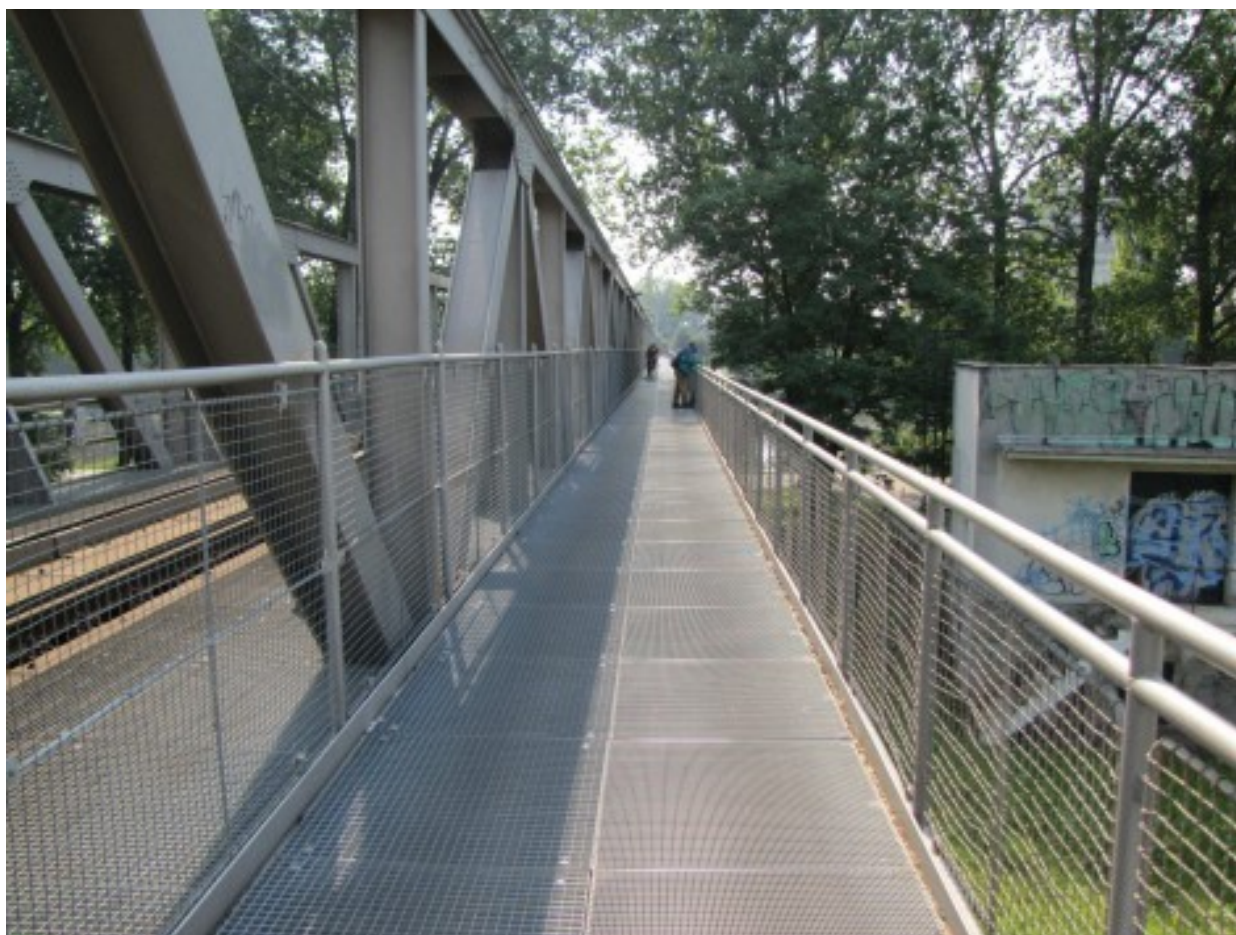
Ilustracja 8: Przykład podwieszenia kładki rowerowej do mostu kolejowego.
