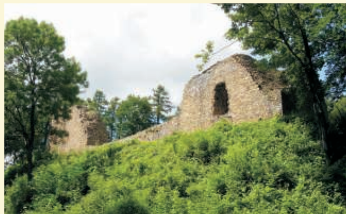
Ruiny zamku. Fot. Arch. Małopolskiego Wojewódzkiego Konserwatora Zabytków
