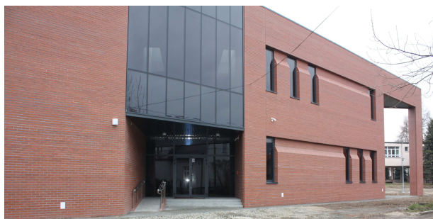
Budowa Miejskiej Biblioteki Publicznej w Myślenicach
