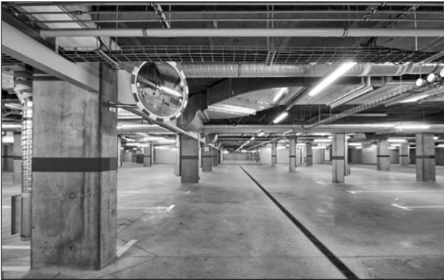
Fot. 2. Garaż podziemny w Centrum Energetyki AGH (fot. KSAF AGH)
