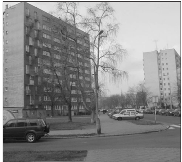
Fot. 8. Budynek komunalny w Warszawie (fot. H. Zaniewska)
