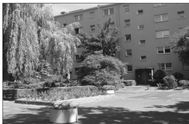
Fot. 1. Budynki spółdzielcze z lat 60. XX w. (fot. H. Zaniewska)
