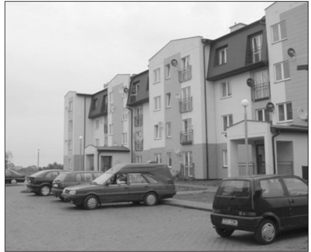
Fot. 7. Budynek komunalny z mieszkaniami socjalnymi w Radomiu (fot. H. Zaniewska)
