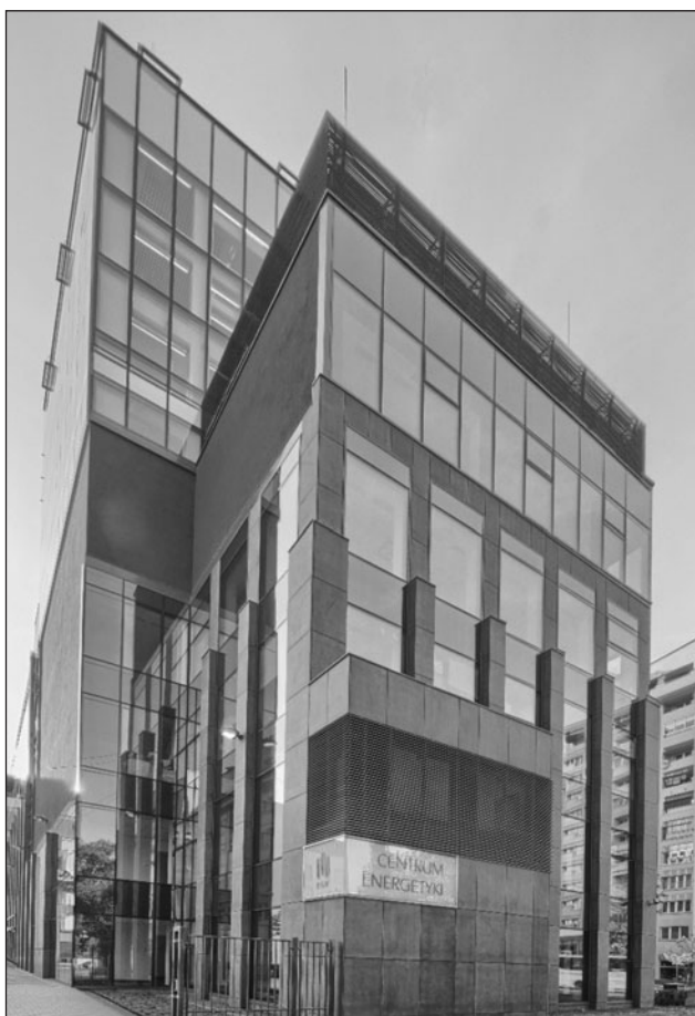
Fot. 1. Budynek Centrum Energetyki AGH (fot. KSAF AGH)
