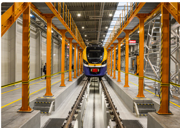
Budowa i wyposażenie zaplecza technicznego do obsługi taboru kolejowego
