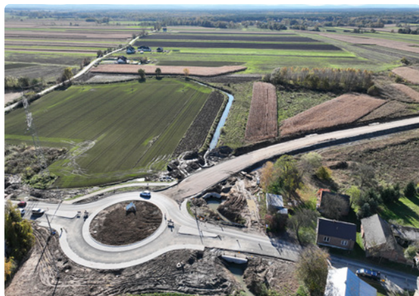
Obwodnica Szczurowej (w trakcie realizacji)
