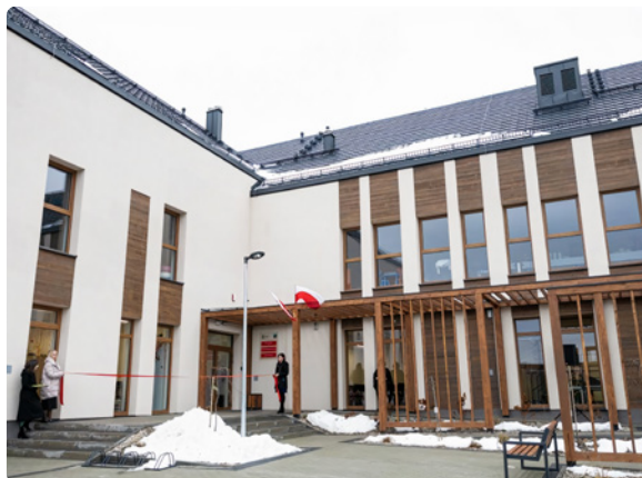
Budowa Centrum Kultury i Rekreacji w Gnojniku
