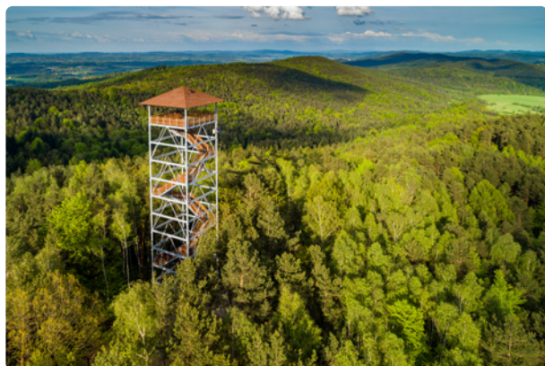
Wieża widokowa na Szpilówce w Iwkowej
